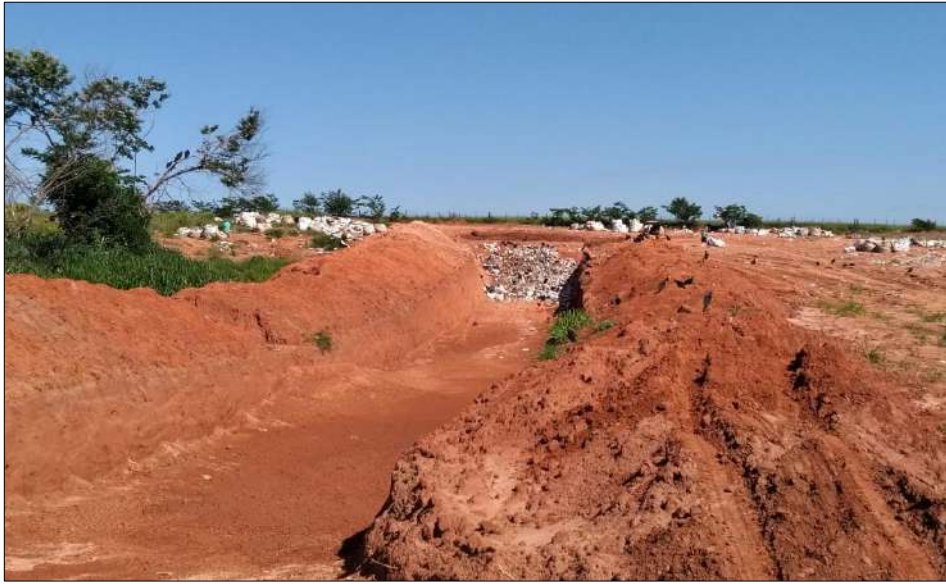
Figura 71 - Aterro controlado de Santo Anastácio.
