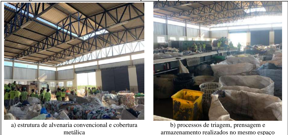
Figura 50 - Edifício onde são realizadas as etapas de preparação dos resíduos da COOPERLIX.
