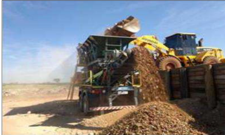
Figura 102 - Beneficiamento de RCC em Rancharia.
