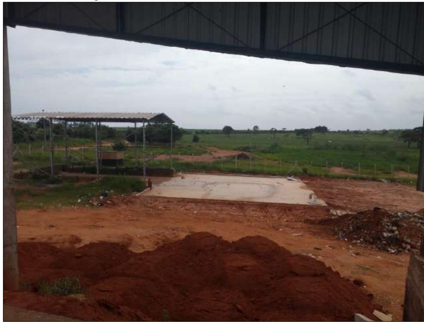
Figura 67 - Unidade de transbordo de Rancharia.
