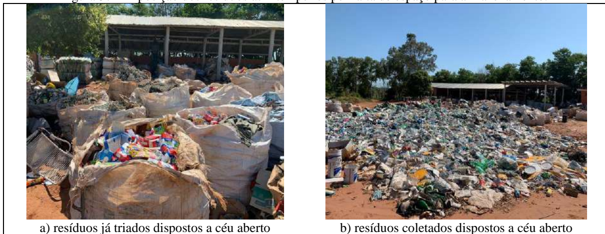
Figura 57 - Exposição dos resíduos às intempéries por falta de espaço para armazenamento.
