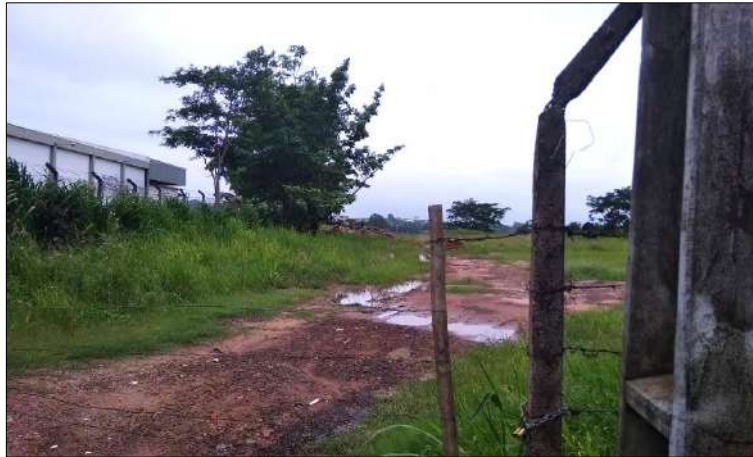
Figura 95 - Área de disposição final de RCC em Álvares Machado.
