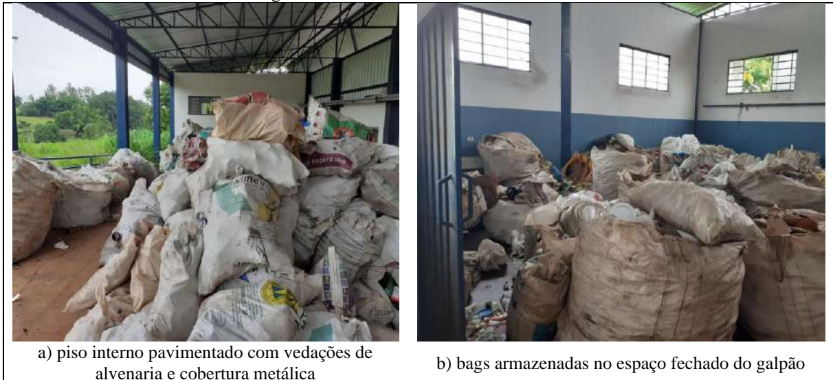
Figura 39 - Estrutura do barracão da ARPV.
