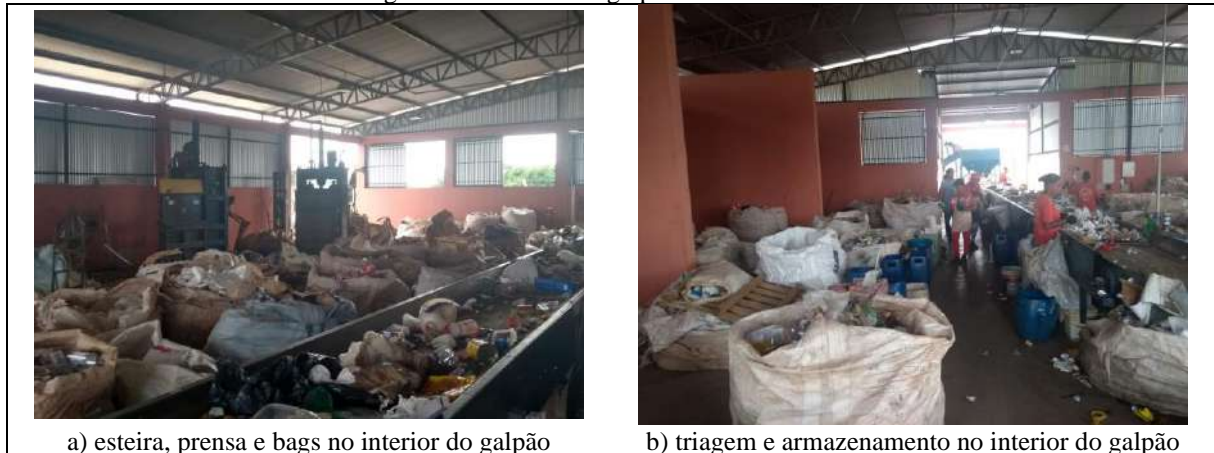
Figura 54 - Interior do galpão da UNIVENCE.
