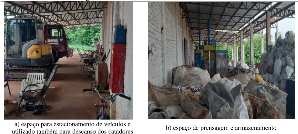
Figura 44 - Laterais do edifício do COOPERMART.
