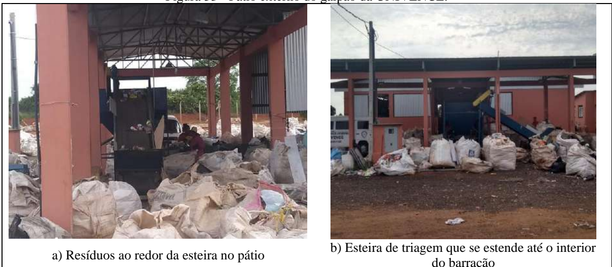
Figura 53 - Pátio externo do galpão da UNIVENCE.
