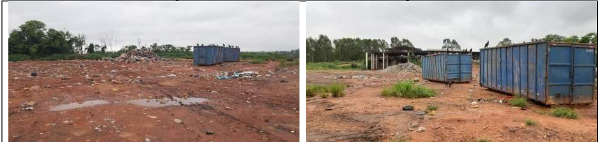
Figura 65 - Unidade de transbordo de Martinópolis.
