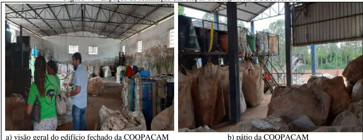
a) visão geral do edifício fechado da COOPACAM
