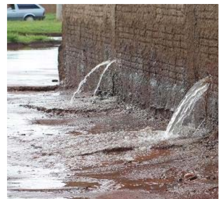
Saída de água pluvial na calçada
