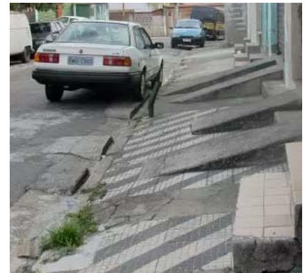
Presença de degraus e rampas
