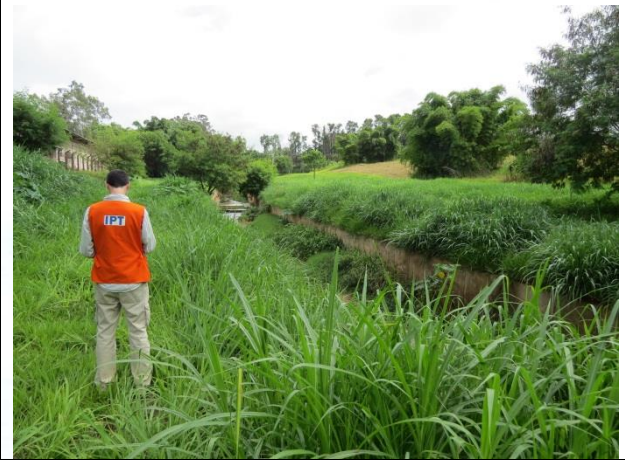
FOTO 18. Vista geral do córrego próximo a rua Ana Jacinta. O córrego apresenta-se canalizado e a céu aberto, os taludes marginais são feitos de concreto. Segundo a COMDEC, a inundação não chega a alcançar os estabelecimentos comerciais no entorno do córrego.
