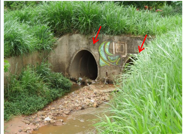
FOTO 20. Detalhe para as estruturas de canalização (ovóide) que atravessam a rua Ana Jacinta. Em períodos de chuvas intensas, esta rua chega a apresentar pontos de inundação.
