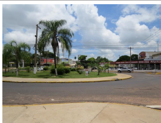
FOTO 11. Vista geral da rotatória na avenida Brasil. Esta área é um baixo topográfico que concentra as águas superficiais da região, contribuindo para o processo de inundação.
