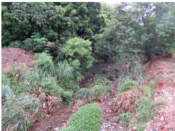
FOTO 1. Vista de um pequeno trecho do afluente do Córrego do Veado que apresenta refluxo quando o sistema de drenagem do Córrego do Veado trabalha afogado, deflagrando a inundação.
