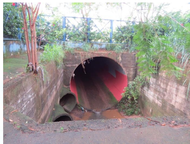
FOTO 6. Vista do córrego do Veado no Parque do Povo. O córrego apresenta-se canalizado e confinado. Este é um dos poucos locais em que o canal pode ser observado.
