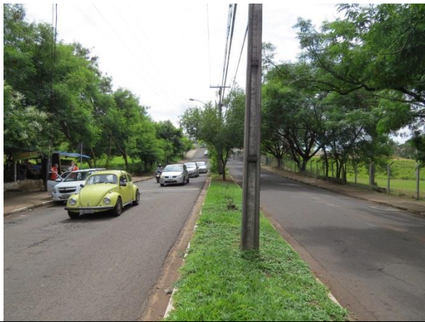
FOTO 17. Vista geral da rua Ana Jacinta. Segundo a COMDEC, esta área apresenta inundação, principalmente na via, não atingindo moradias.
