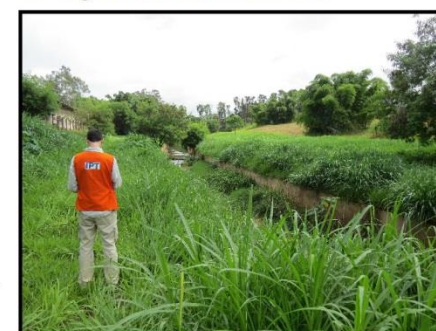
Vista geral do córrego próximo a rua Ana Jacinta, que apresenta-se canalizado e livre, os taludes marginais são feitos de concreto.
