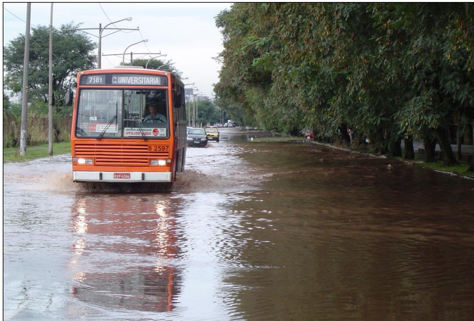
Figura 20 – Situação de alagamento. (Sirden-CTGeo – IPT).
