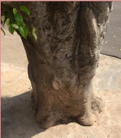
Imagem 04: árvore sem nenhuma área permeável. Nunca coloque cimento/concreto até o tronco. Aumenta a afloramento de raízes causando danos na calçada, além de causar deformações no tronco.
